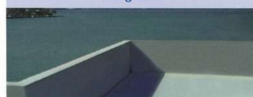
Dak yang Dilalui Air
