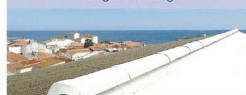
Atap Asbes & Kayu
