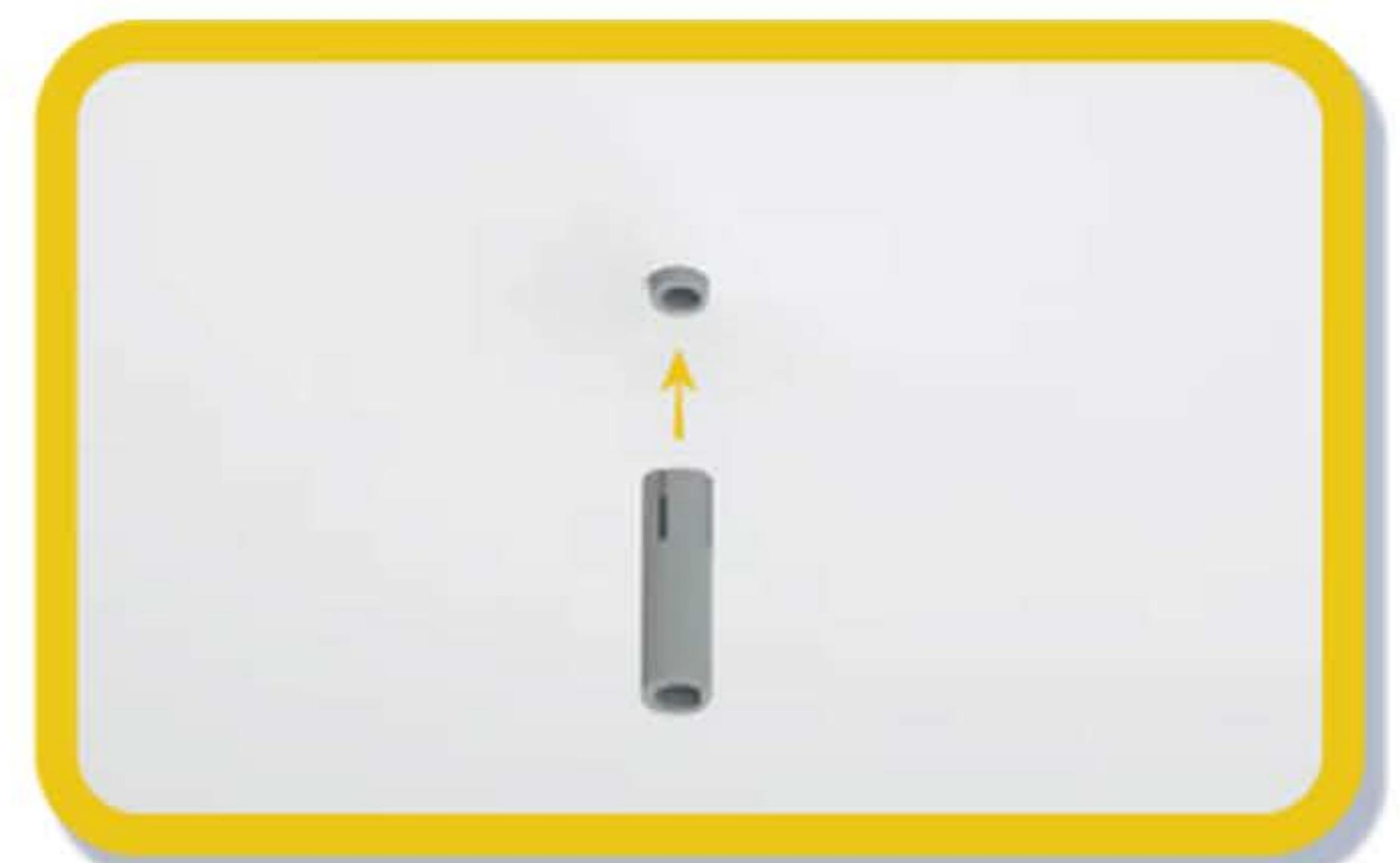
Pasang fisher ke dalam lubang pemasangan tiang hanger.
