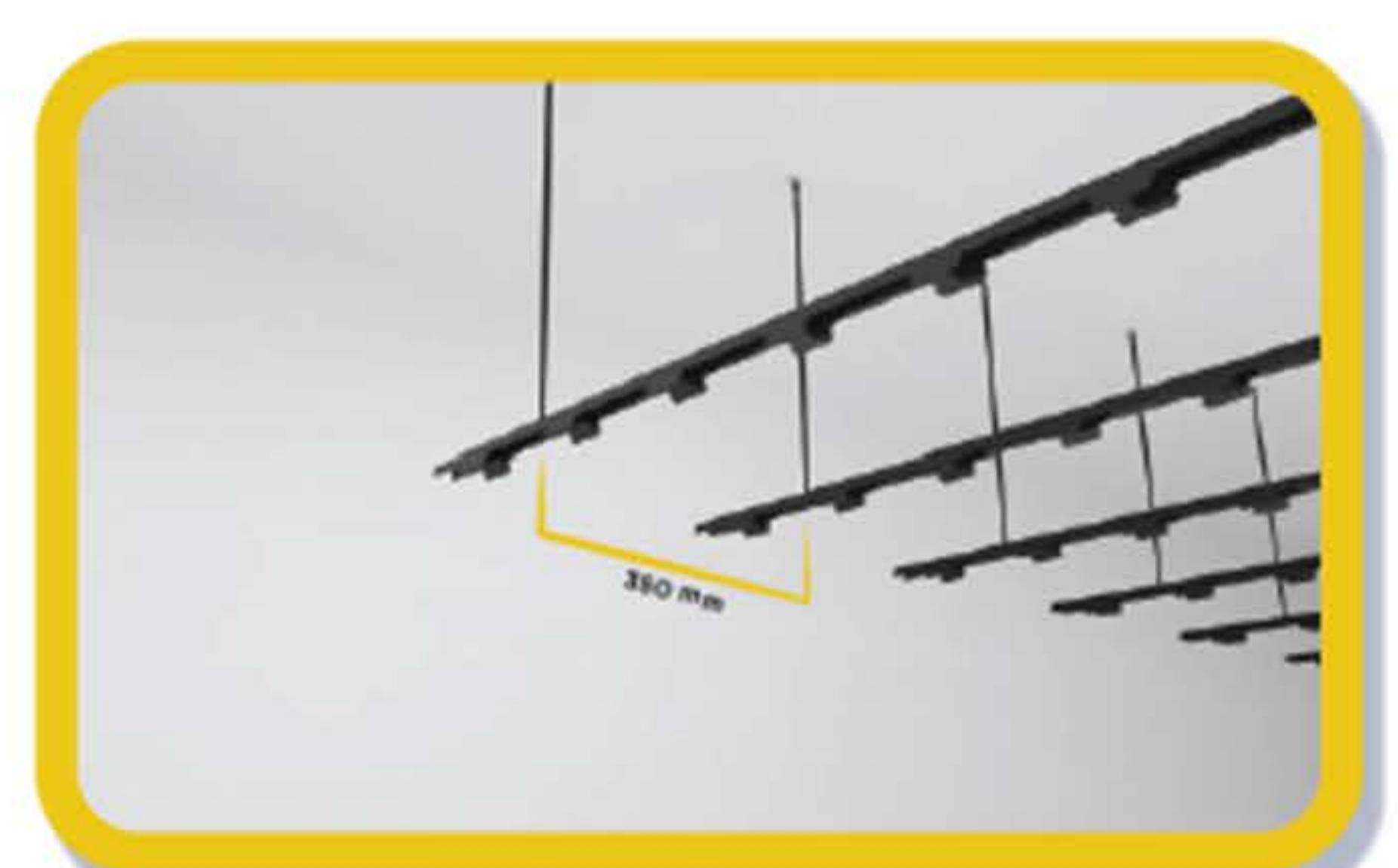
Ulangi langkah pemasangan joist sebelumnya pada titik lain dengan jarak pemasangan 350mm.
